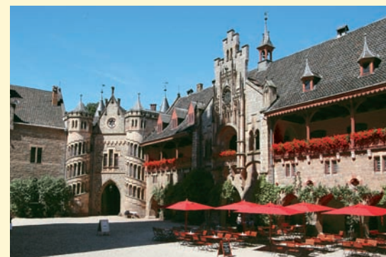
▲ La romantique cour intérieure du château de Marienburg
