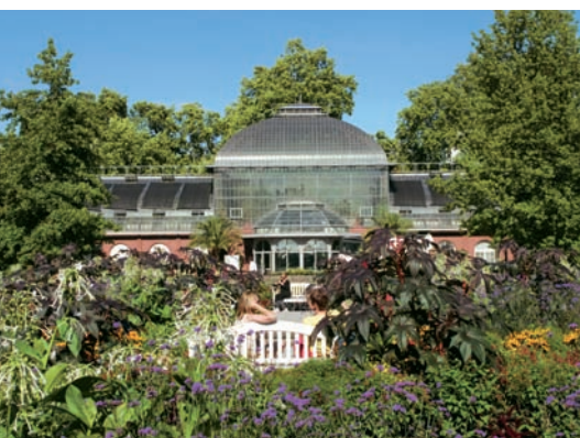
▲ La partie centrale reconstruite de ce bâtiment historique est aujourd'hui l'entrée principale
